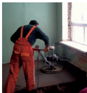
2.4. attēls. Betona izlīdzināšanas process.
