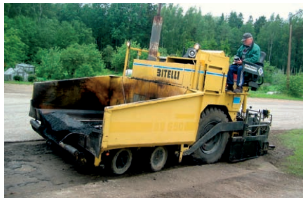
3.2. attēls. Asfalta ieklāšanas process.
