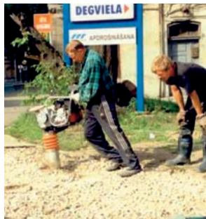
2.2. attēls. Šķembu blietēšana ar vibroblieti.
