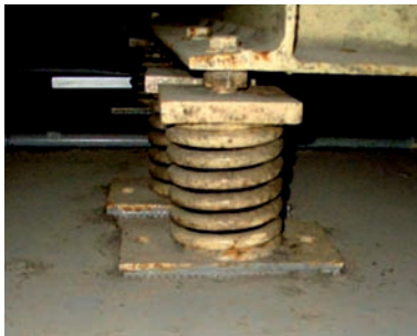
11.1. attēls. Vibrācijas dzēšana, izmantojot atsperes.
